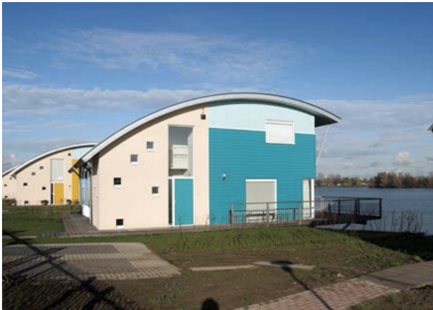
08 : Maison amphibie à Maasbommel « Projet Ge12, La lutte contre les inondations et la montée des eaux, Étude du cas de Dordrecht, Pays-Bas »
