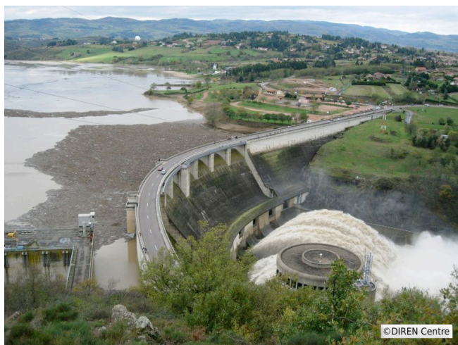
1 - Barrage de Villerest,
